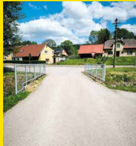
zábradlí U Splavu
