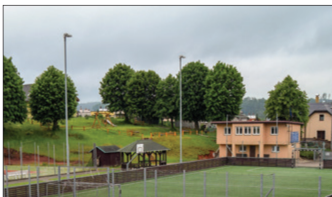
Součástí areálu jsou i šatny včetně sprch a malé klubovny
